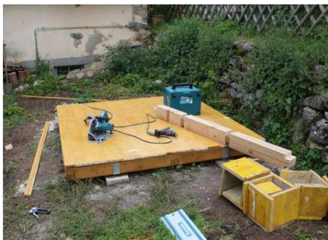
Le plancher est posé et découpé à la bonne taille
