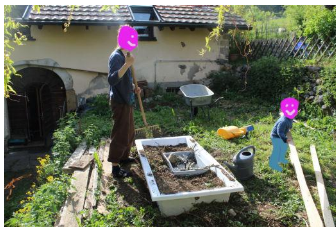
Trou creusé, baignoire installée
