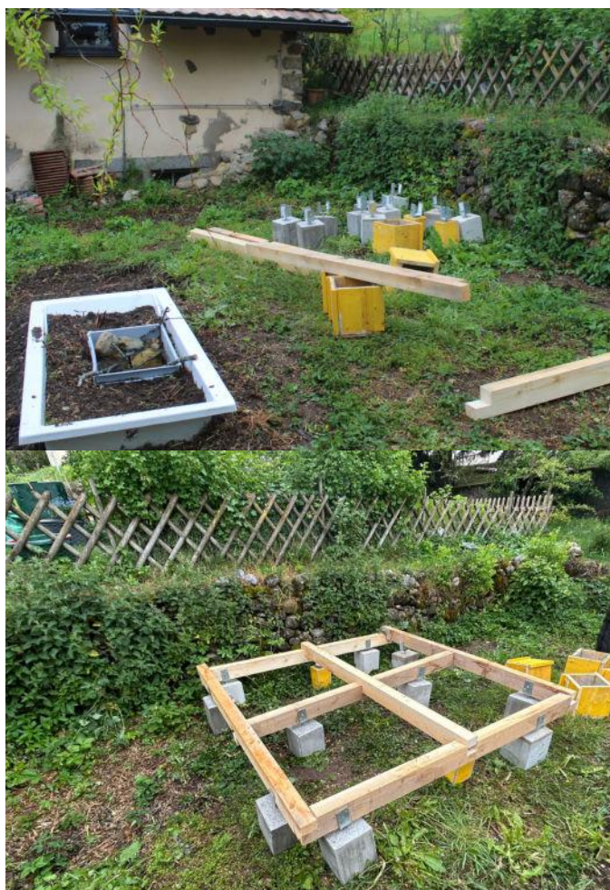
Préparation de la pose des fondations
